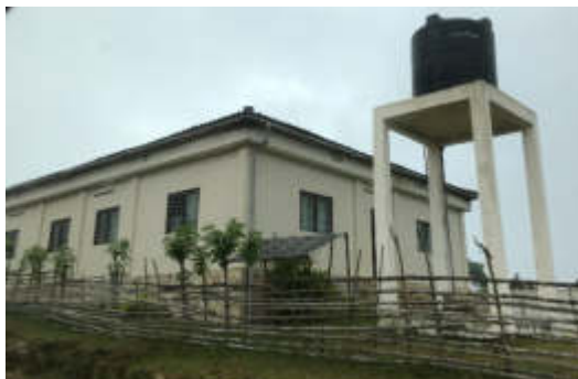
Krankenstation mit Solarpaneele und Wassertank
